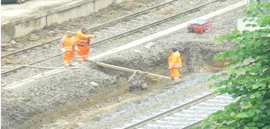
Bilder der vermutlichen Entgleisungsstelle vom Unfall 09.06.2013. Aufnahme datum: 27.06.2013. Das Wasser wird unter dem Gleisbett hindurchgeleitet und anschließend mit einer Tauchpumpe abgepumpt.
